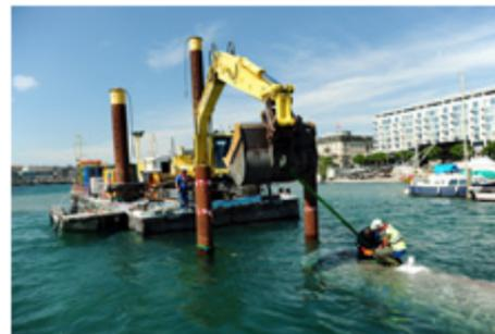
Une fois la conduite en place, on la coule petit à petit en détachant les flotteurs qui la maintenaient proche de la surface. Des plongeurs effectuent cette opération qui lui permettent de venir se déposer le plus délicatement possible dans une tranchée creusée sous l'eau.
